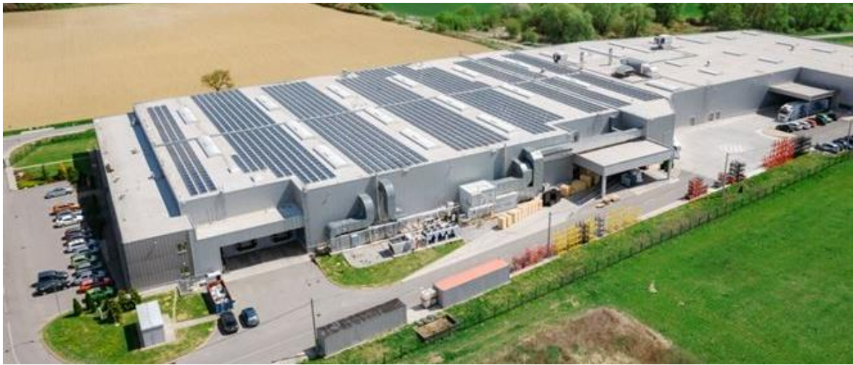
Figura 23. Sistemul fotovoltaic ca resursă locală într-o întreprindere industrială din Humenne [31]
