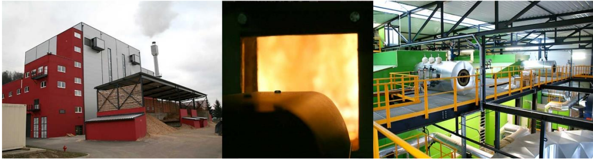
Figura 28. Centrală electrică de aşchii de lemn Bardejov [36]
