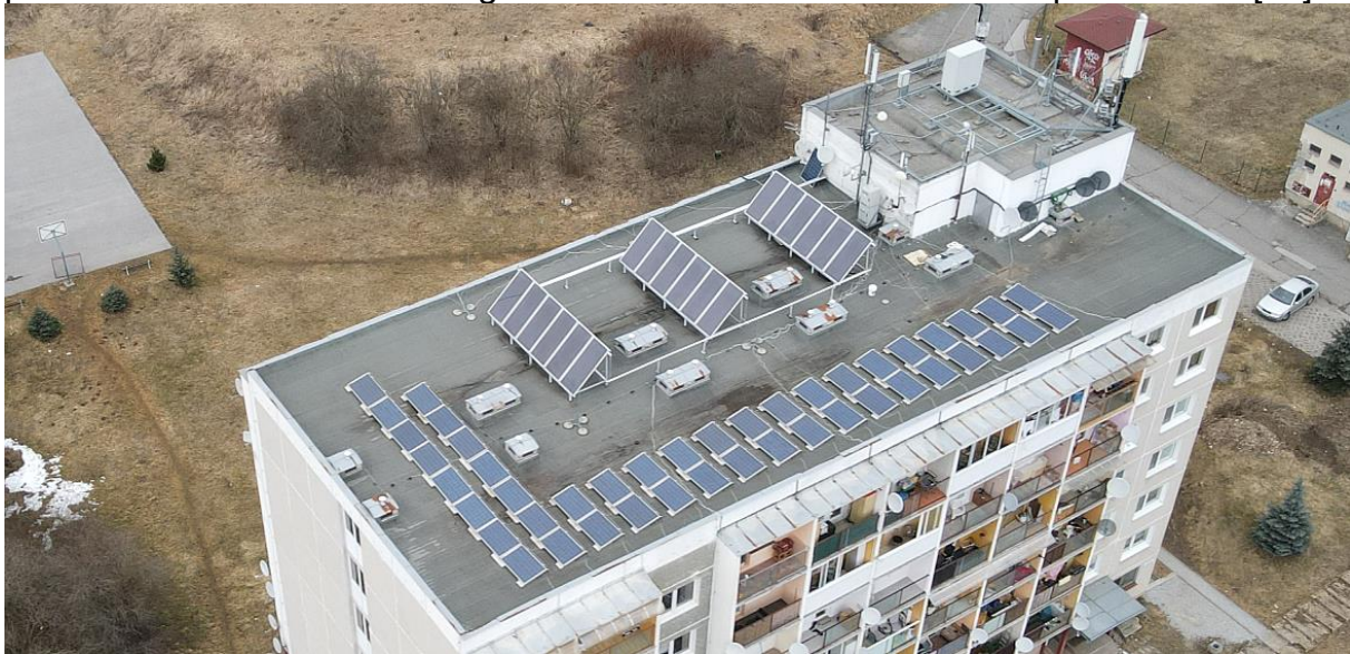
Figura 22. Sistem solar și fotovoltaic pe un bloc de apartamente în Spišská Nová Ves [30]
