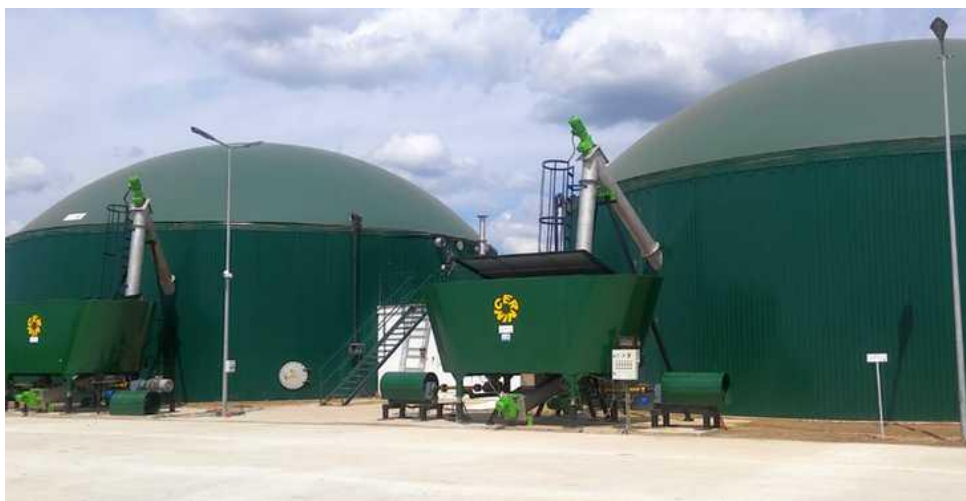
Figura 27. Instalație de cogenerare a biomasei [26]
