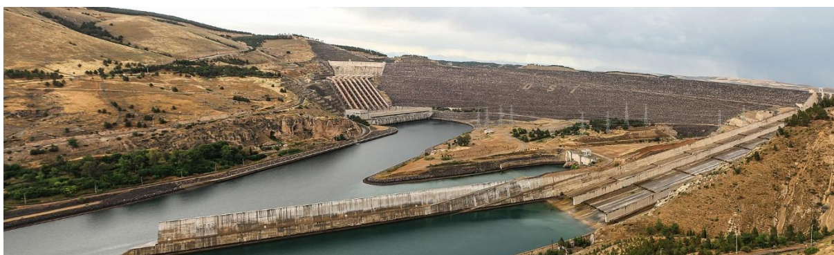
Figura 7. Barajul Atatürk, parte a Proiectului Anatolia de Sud-Est, este cea mai mare sursă de energie hidroelectrică din țară
