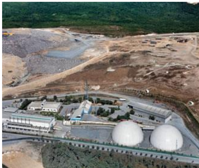
Figura 13. Centrala electrică pe gaz Odayeri
