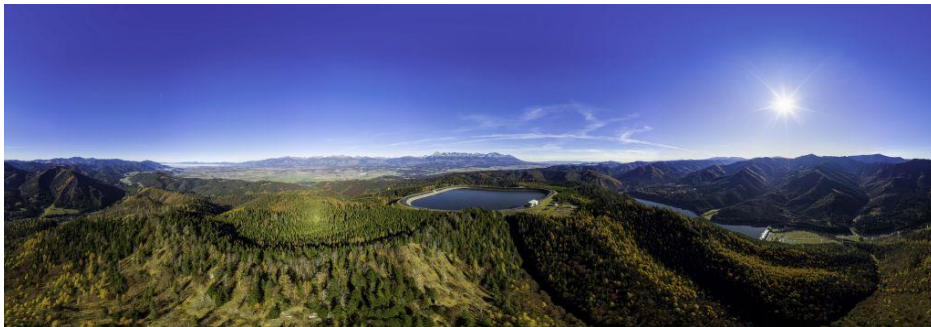
Şekil 30 Čierny Váh pompalama Hidroelektrik santrali [39]
