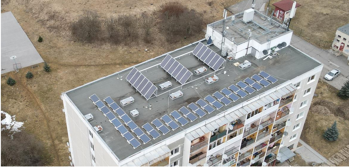
Şekil 22 Spišská Nová Ves'teki bir apartmanda güneş enerjisi ve fotovoltaik sistem [30]
