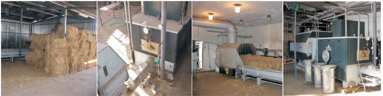
Şekil 27 Saman Turnňa nad Bodvou için kazan [35]
