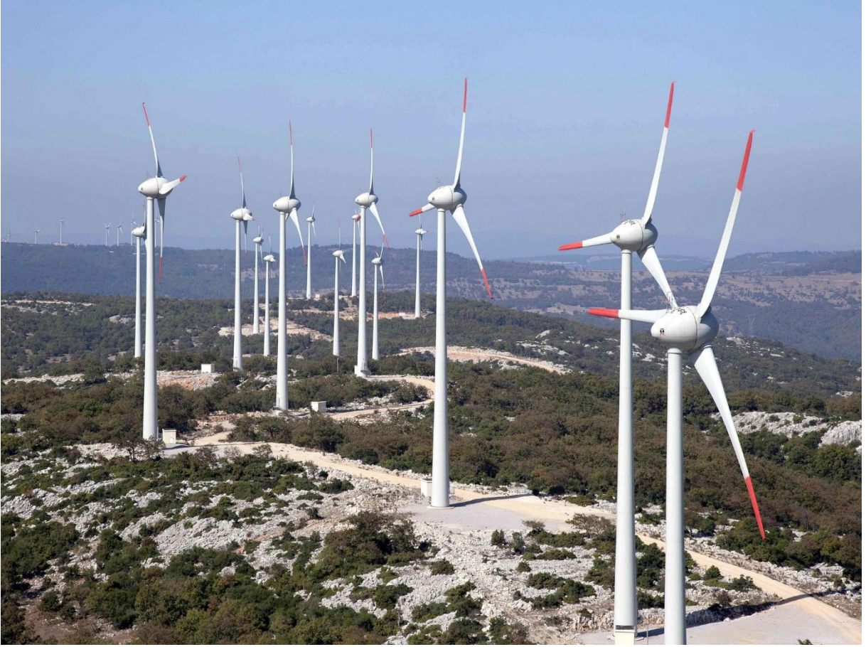
Şekil 10. Soma Rüzgar Enerji Santrali – RES Jeotermal enerji
